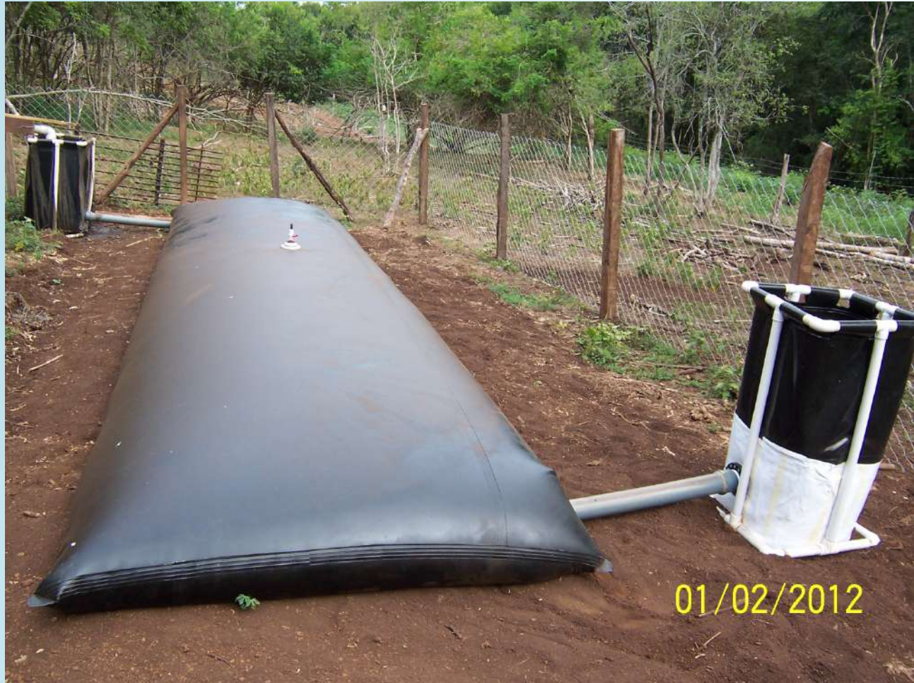
Fotografía: Digester flexible Energías del Sol S.A. Tamaño: 5 metros cúbicos.
