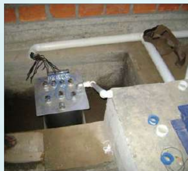
Fig. 20. Tanque disipador de energía con resistencias blindadas tipo calefón. Fuente: Prog. Hidroenergía. IHH- UMSA
