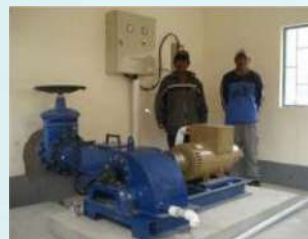
Figuras 1, 2 y 3 Turbina Pelton (izquierda), Turbina Banki (centro), Equipo completo (derecha) . Fuente: Prog. Hidroenergetico, IHH – UMSA
