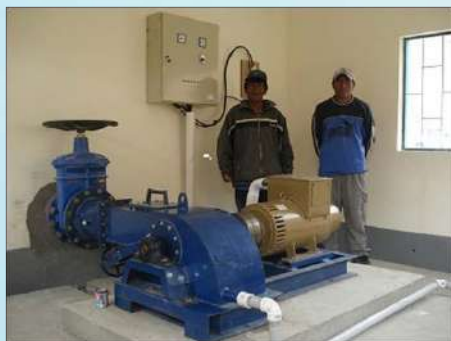
Fig. 19. Equipo completo de generación con regulador de velocidad electrónico. Proy. Sud Lípez, Potosí. Fuente: Prog. Hidroenergía. IHH- UMSA
