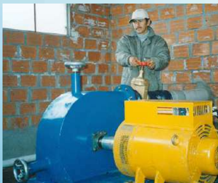
Figuras 6, 7 y 8. A la izq. Turbina Pelton con inyector tipo caracol y dos toberas de accionamiento externo, al centro corte transversal y a la derecha turbina fabricada, nuevo desarrollo de turbinas Pelton. Fuente: Prog. Hidroenergía. IHH-UMSA
