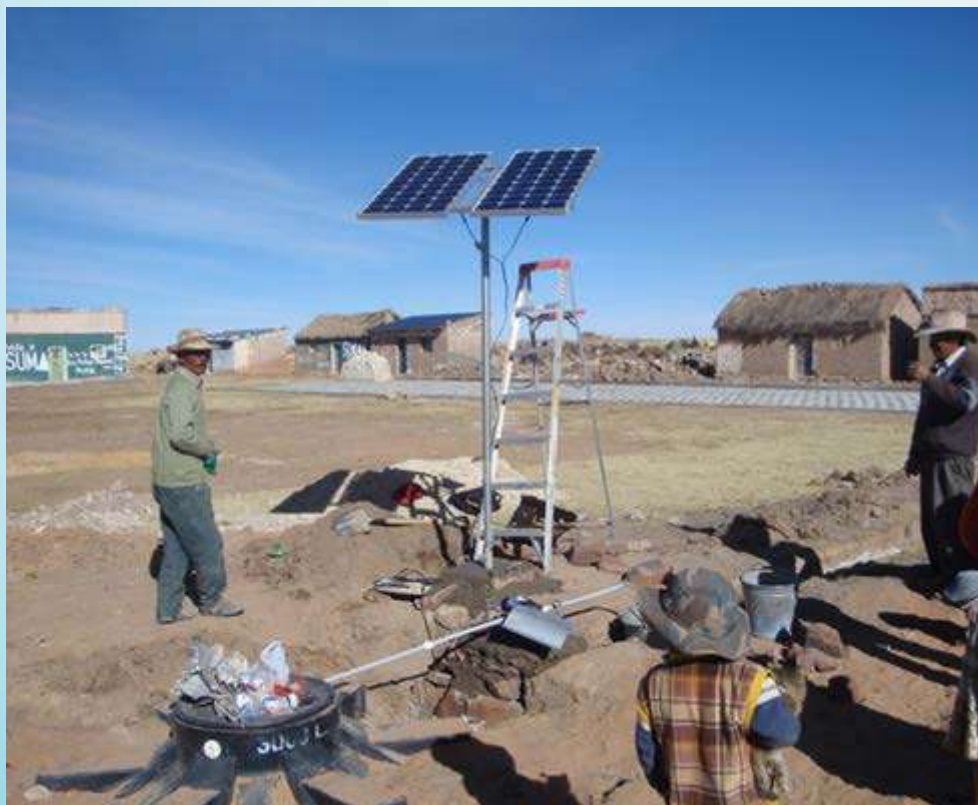
Figura4. Instalación de un sistema de bombeo fotovoltaico superficial (Villa Nueva – Oruro)
