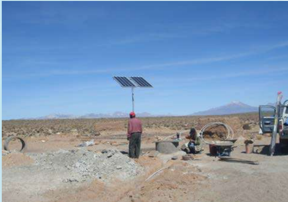
Figura 3. Instalación de un sistema de bombeo fotovoltaico sumergible (Uyarani – Oruro)
