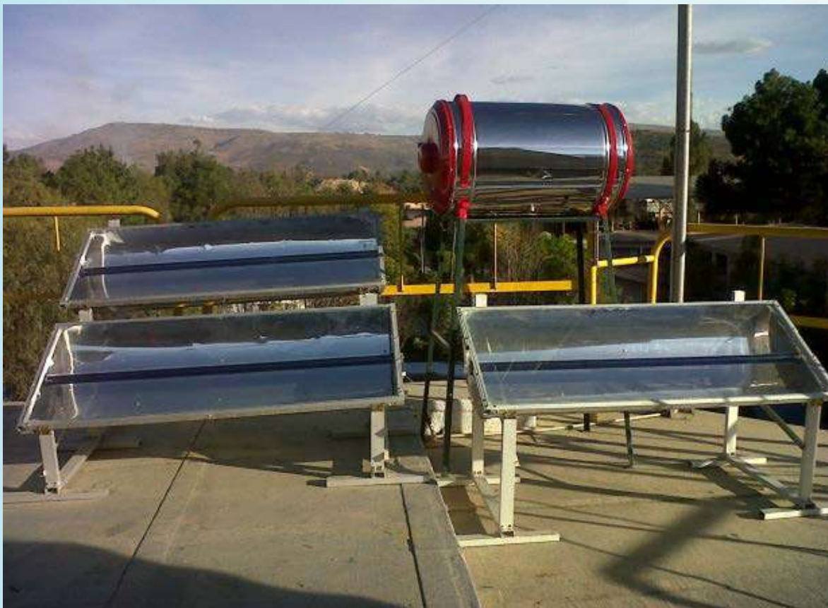
Figura 4. Fotografía del sistema de recolección solar térmico instalado.
