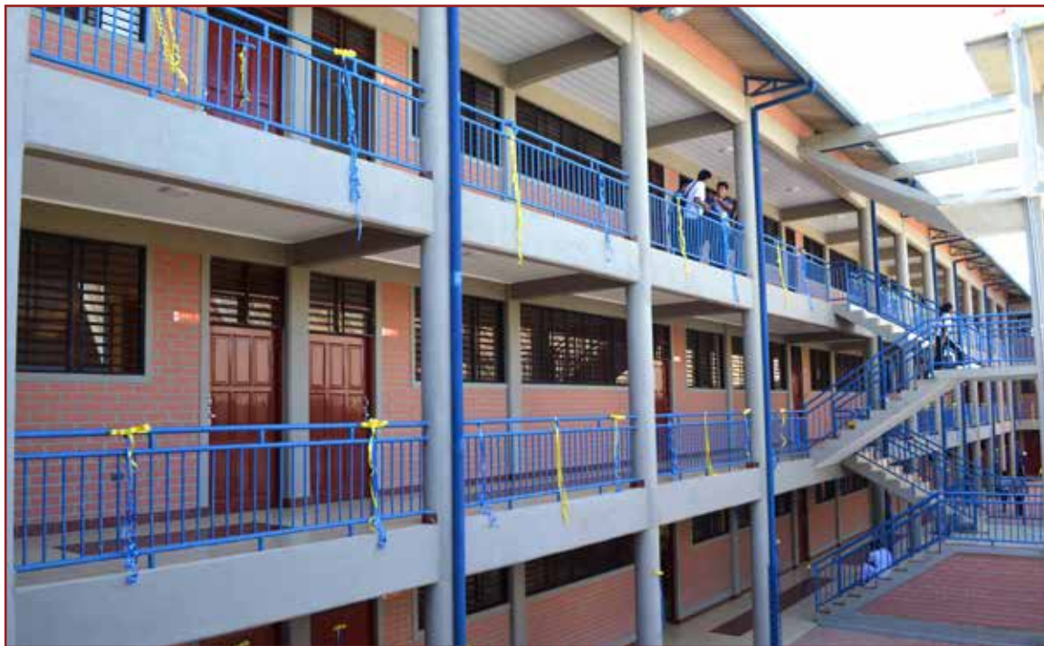
La moderna infraestructura de la Unidad Educativa “San Antonio de Padua” de Ivirgarzama, en el Trópico de Cochabamba, permitirá brindar formación técnico-humanística a estudiantes de Secundaria.
